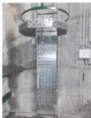
Protection d'une échelle à crinoline avec un obturateur
