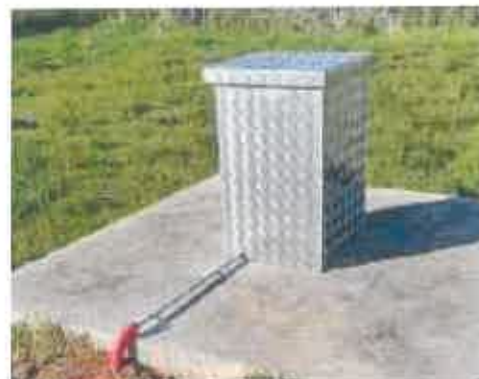
Mise en sécurité d'un piézomètre
